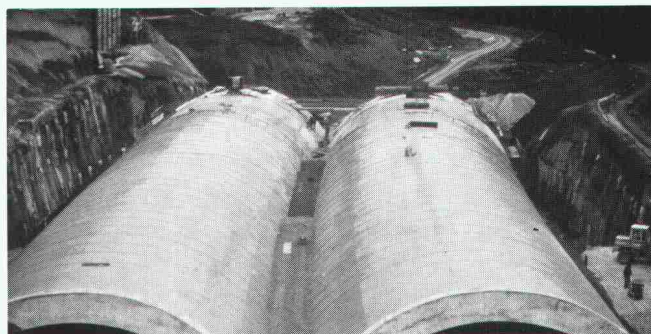
Tunnel Aichelberg, Autobahn A8 Karlsruhe-München, abgedichtet mit 7000 m 2 Sarnafil Typ FP 4 mm.
