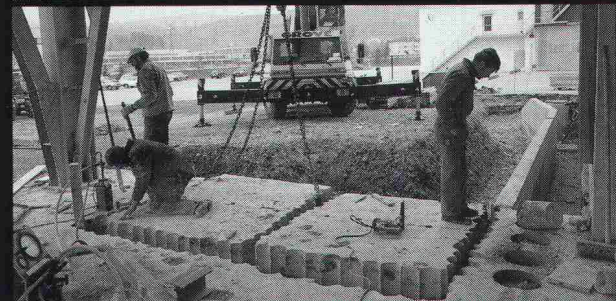
Der Ausbruch einer stark armierten 90 cm tiefen Beton-Fundamentplatte konnte nur mit Reihenbohrungen ausgeführt werden.
