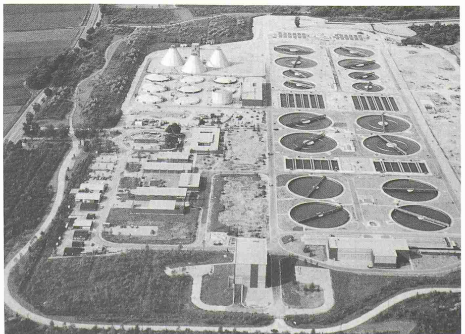
Bild 2. Klärwerk München II mit 32 grossen fugenlosen und rissfreien Betonbauwerken (Stöver)
