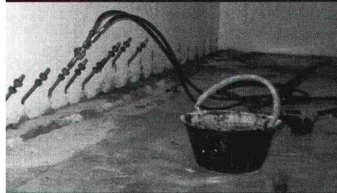
Elastische Abdichtungs-Injektion-Rascoflex in einer Zivilschutzanlage.
