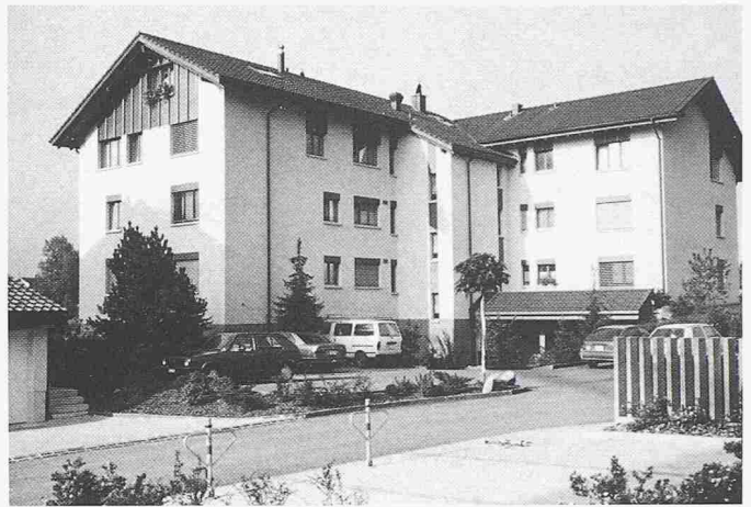
Mehrfamilienhaus Rietwies, Sonnenriedstrasse 6, Wangen; Architekten: Eggenberger & Schättin AG, Wangen SZ
