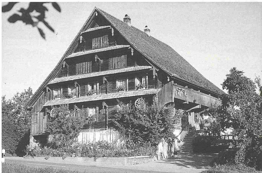
Bild 3. Der Schweizer Holzbau hat eine ernstzunehmende Tradition. Was oftmals disqualifizierend als Heimatstil eingestuft wird, ist eine mit bestimmten, traditionell einfachen Mitteln optimierte Lösung einer Bauaufgabe
