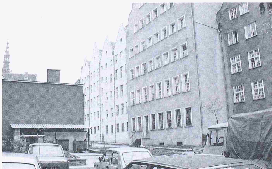
Bild 6. «Ausgekehrte» Hofseite von Gebäuden an der Hauptstrasse in Danzig
