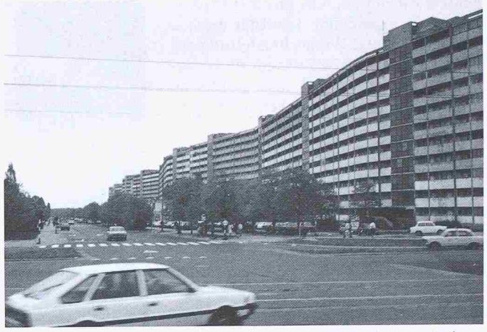
Bild 2. Im Grundriss schlangenförmiger, 800 m langer Gebäudekomplex (Wohnungen)
