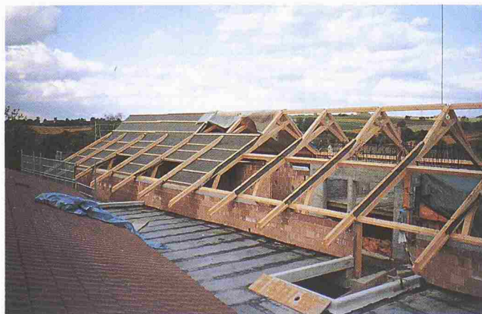
Bild 6. Ansicht der fertig aufgerichteten Binder
