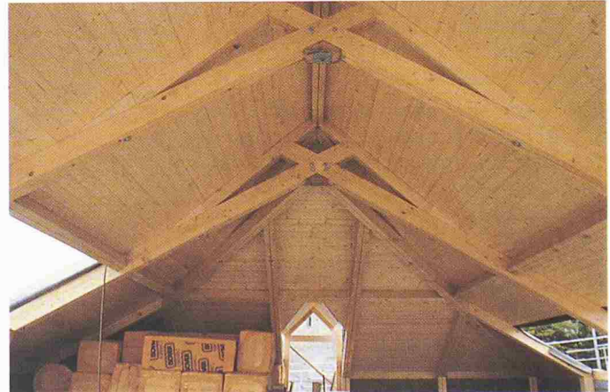
Bild 7. Innenansicht der Konstruktion nach dem Aufbringen der Dachschalung
