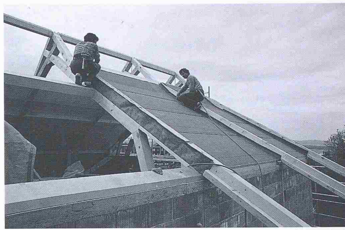
Bild 9. Verlegungen und Verschweissen der Dampfsperre
