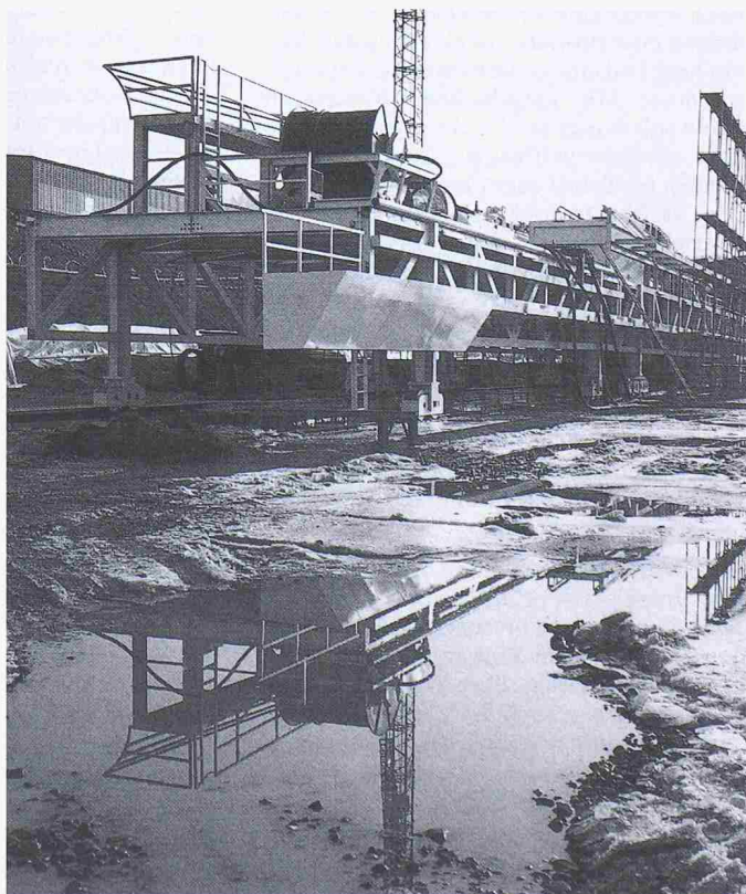
Bild 2 zeigt die Startgrube mit der Montageplattform für die über 1000 t schwere sowie 12,5 m lange Vortriebsmaschine
