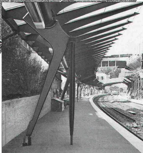
Stahl- und Industriebau
