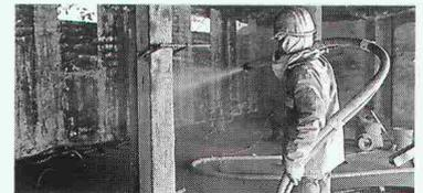
Zur Reprofilierung und strukturellen Verstärkung des Bauwerkes wird bei Renesco auch das Spritzbeton- und Spritzmörtel-Verfahren eingesetzt.
