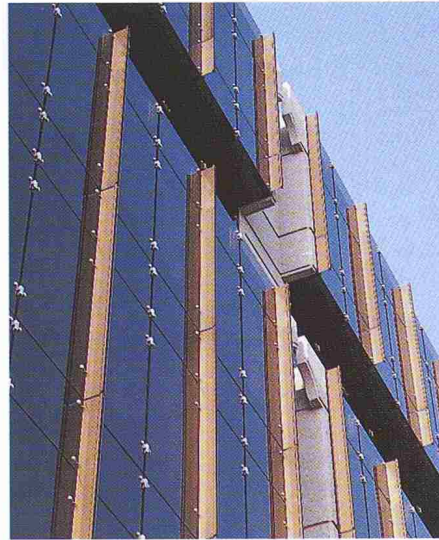
Im 4. Obergeschoss ist die Fassadenhaut durch einen Rücksprung gekennzeichnet und bewirkt einen harmonischen Ausgleich in der Linienführung der Fassade
