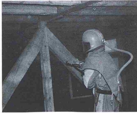
Die alte Tragkonstruktion wird sandgestrahlt und bleibt unter dem neuen Warmdachaufbau sichtbar
