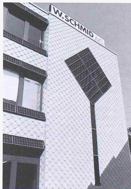
Bild 3. Die Solarzellen sind einerseits an Sturze und Bänken der Fenster montiert, andererseits in die Fassade integriert
