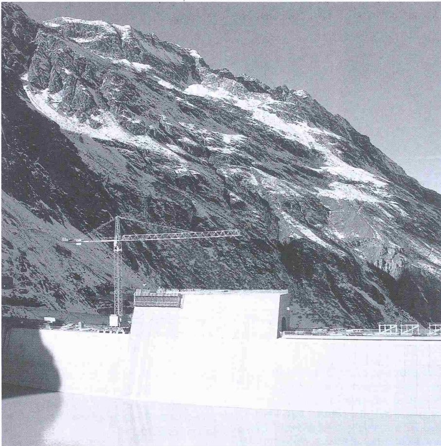
Bild 5. Die Staumauer Mauvoisin wird zur Zeit um 13,5 m erhöht, wodurch der Inhalt des Stausees um 17% auf 210 Millionen m 3 vergrößert werden kann. Das ermöglicht eine jährliche Mehrproduktion von 100 GWh im Winter, bei einer entsprechend gleichen Minderproduktion im Sommer (Bild Quinche).
