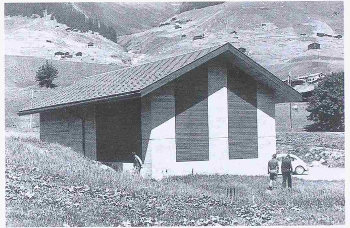
Bild 4. Eines der wenigen in den letzten 10 Jahren neuerstellten Kleinwasserkraftwerke: Zentrale Val Giuf bei Sedrun mit einer Ausbauleistung von 1,5 MW und einer Jahresproduktion von 6,2 GWh.
