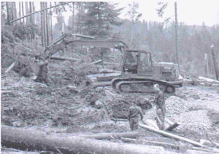
Nach den grossen Sturmschäden vom Februar dieses Jahres: Angehörige der Schweizer Armee beim Strassenbau in schwierigem Gelände
