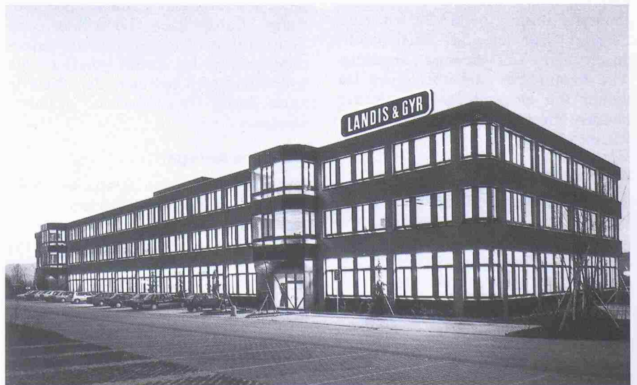
Bild 1. Neuerstelltes Geschäftshaus in Steinhausen mit beispielhafter integraler Gebäudetechnik
