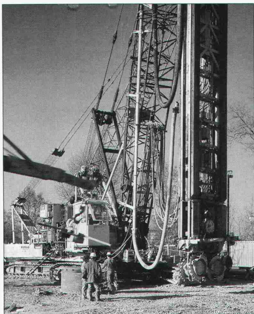
Schlitzn mit der Hydrofräse „im Cher“ in Opfikon/Glattbrugg in ARGE ausgeführt.
