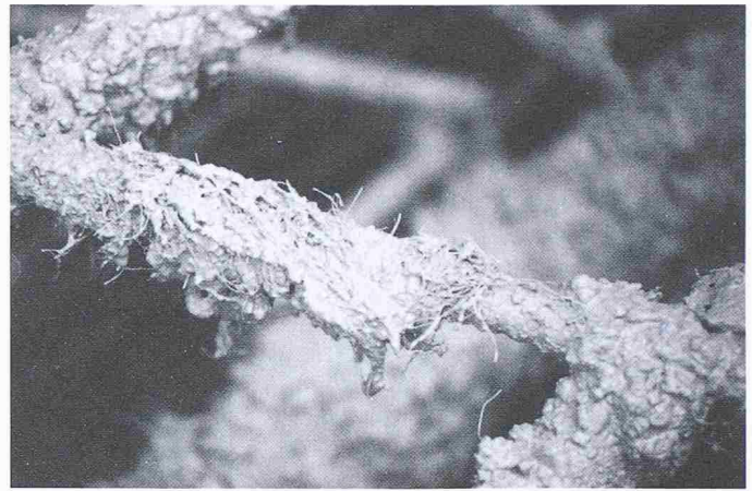
Bild 10. Faser-Entmischung beim Betonieren von Wänden im freien Fall
