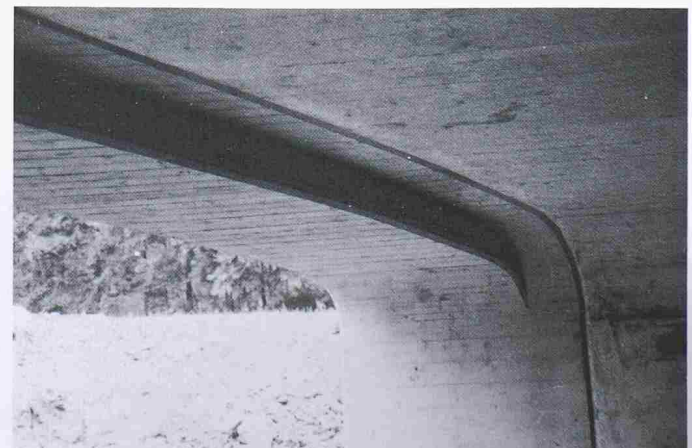
Bild 15. Unter der Brücke ist die ausgeführte Verbreiterung gut erkenntlich
