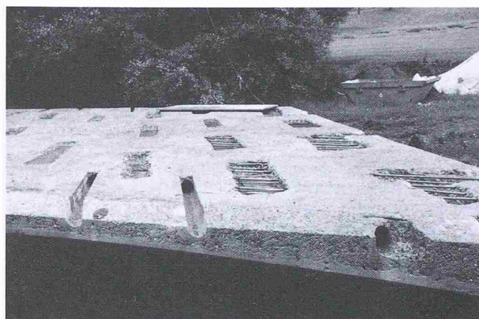
Bild 9. Die verbliebene Substanz der alten Brücke
