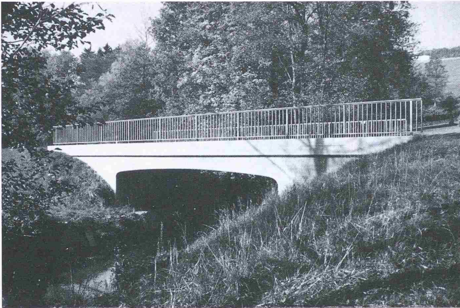
Bild 16. Zustand nach der Sanierung
