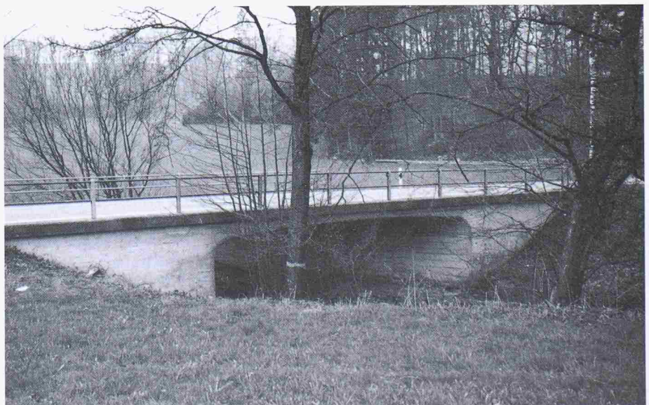
Bild 1. Zustand vor Baubeginn
