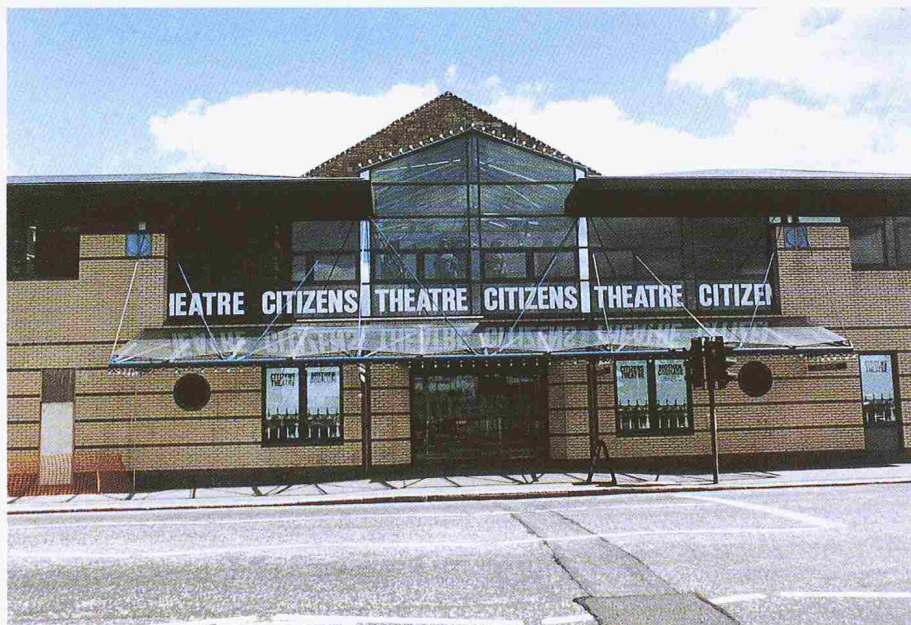
Citizen's Theatre, Foyeranbau mit «Gesicht» zur Strasse
