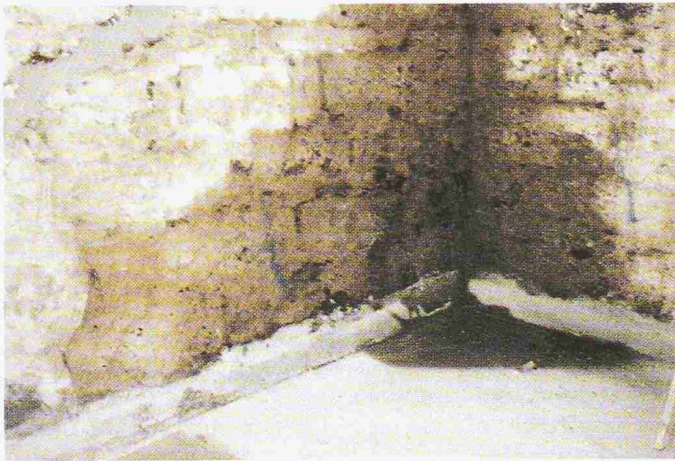
Bild 2. Mauerwerkschaden durch aufsteigende und hygroskopische Feuchtigkeit
