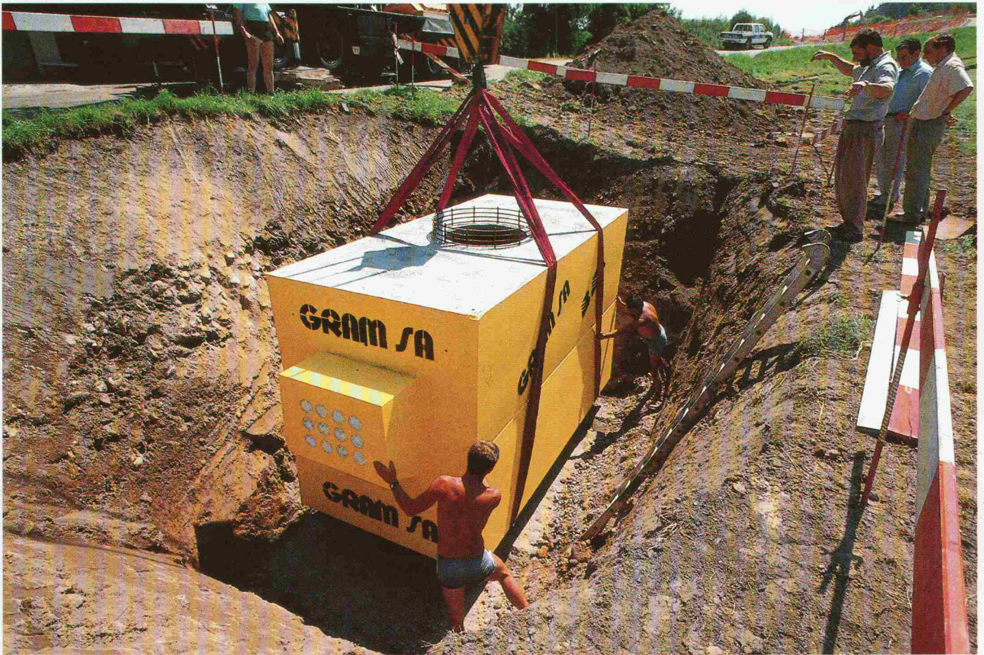
Baustelle: PTT Bulle
