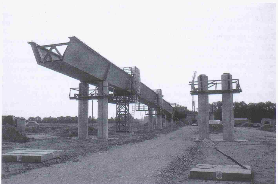
Bild 5. Viadukt «Bois de Rosset» während der Montage
