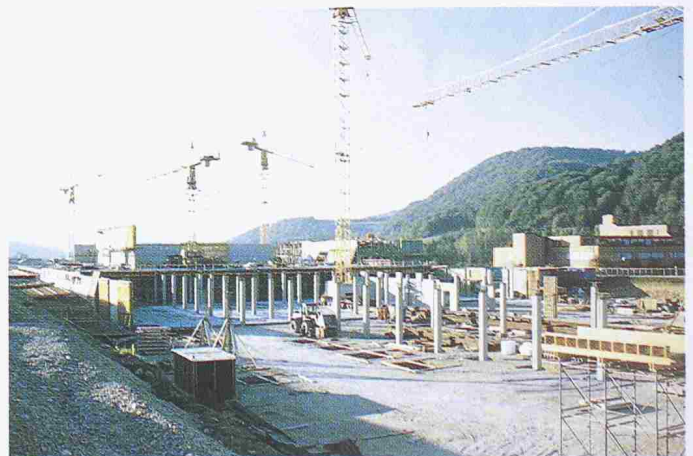
Bild 7. IKEA, Rohbau Blocklager
