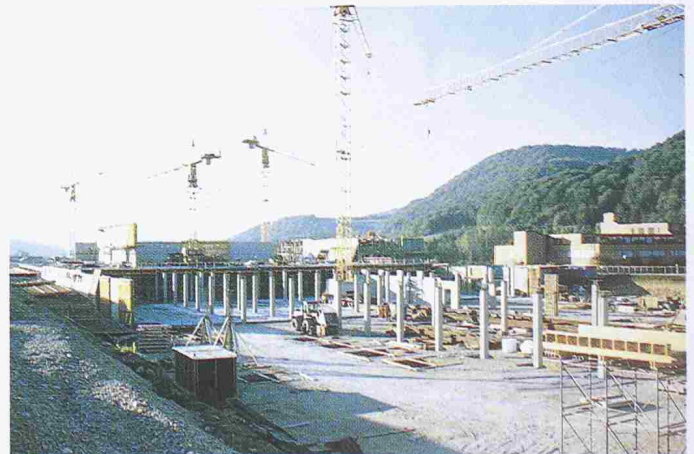
Bild 7. IKEA, Rohbau Blocklager
