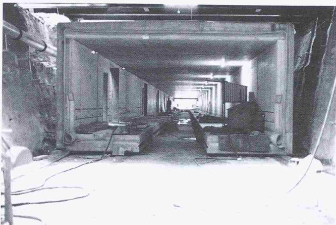
Bild 5. Vorschub des Tunnelkastens
