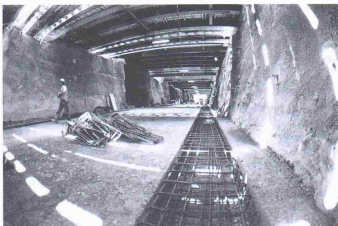
Bild 3. Vernagelte Steilwand und Hilfsbrücken
