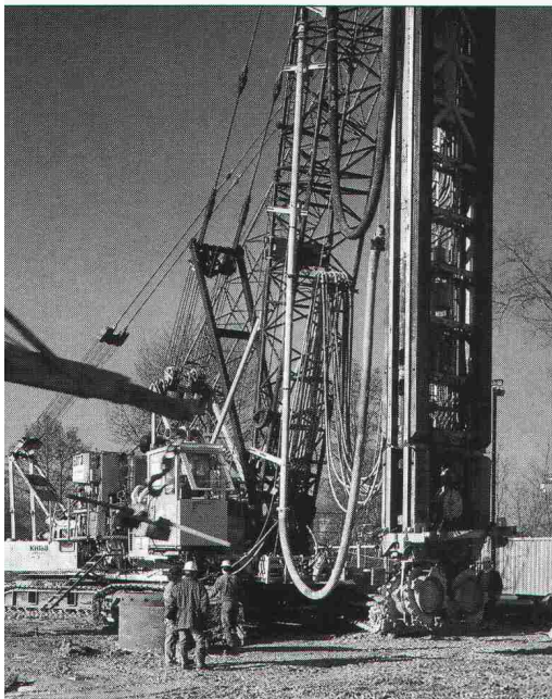
Schlitzwände mit der Hydrofräse „im Cher“ in Opfikon/Glattbrugg in ARGE ausgeführt.
