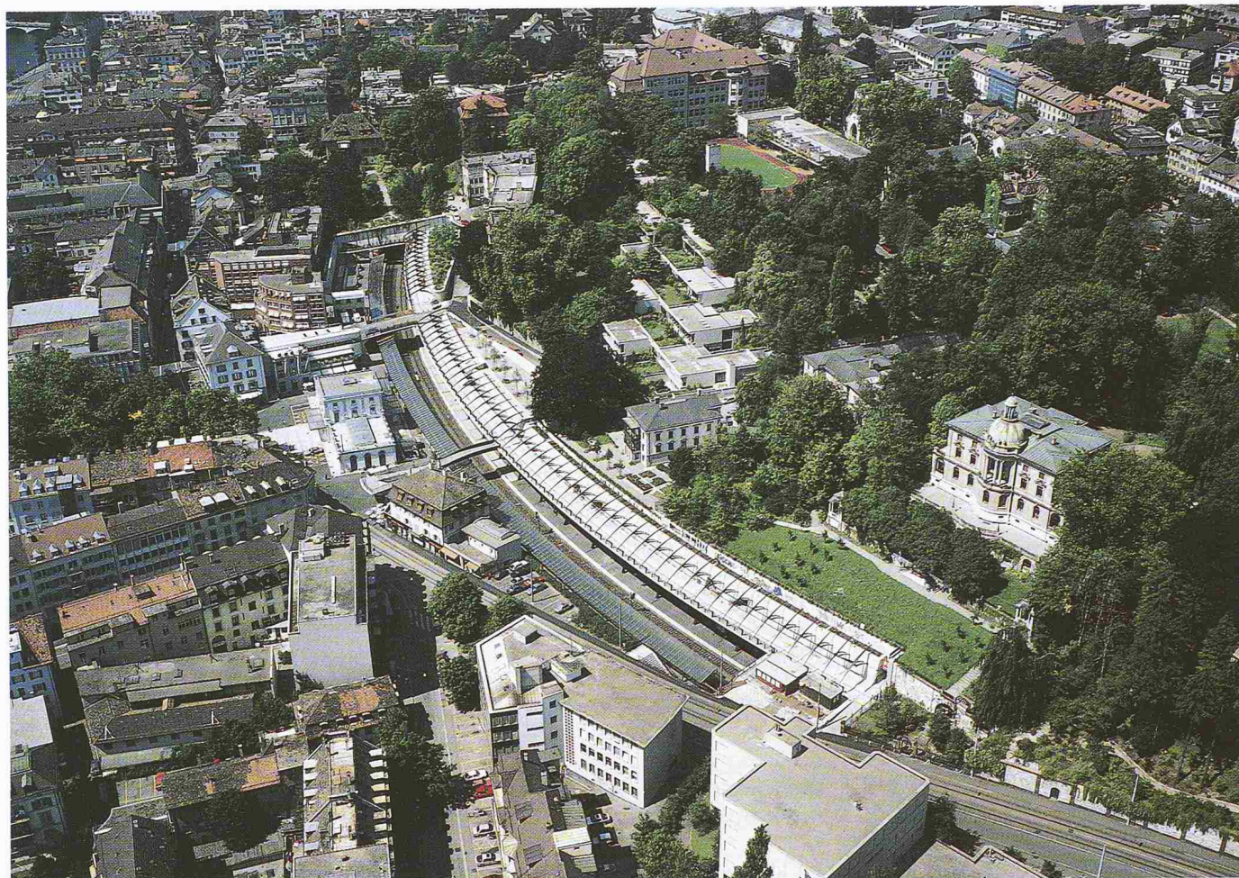
Bahnhof Stadelhofen mit dem historischen Abfertigungsgebäude (links, Bildmitte) als Abschluss der Allee bis zum See, den mit Glas überdeckten Hausperron und der markanten Galerie (heute noch nicht begrünt), welche den Übergang von Gleis 2 und 3 zur natürlichen Hangkante bildet
