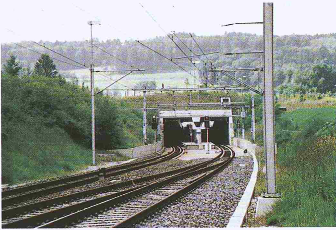
Bild 4. Portal Zürichbergtunnel/Station Stettbach
