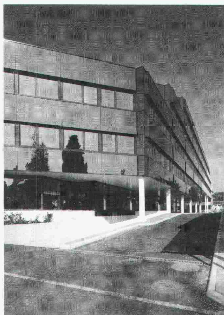
Gebäude: «Centre Informatique et électronique», Morges Ingenieur: Monod-Piguet, Lausanne Architekt: RS Architectes, Lausanne Unternehmer: Luini SA, Tolochenaz Foto: Germond, Lausanne
