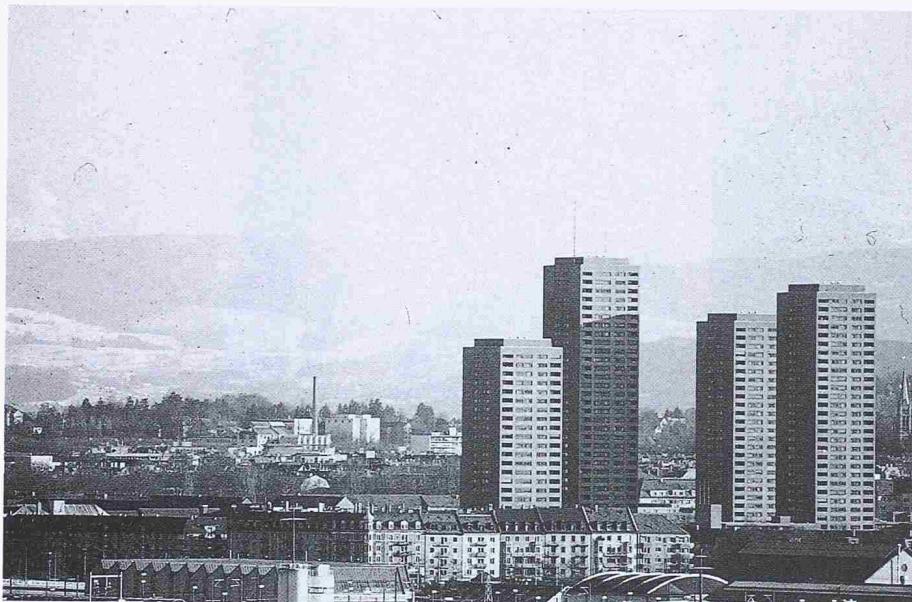
Bild 13. Hochhäuser der Siedlung Hardau in Zürich
