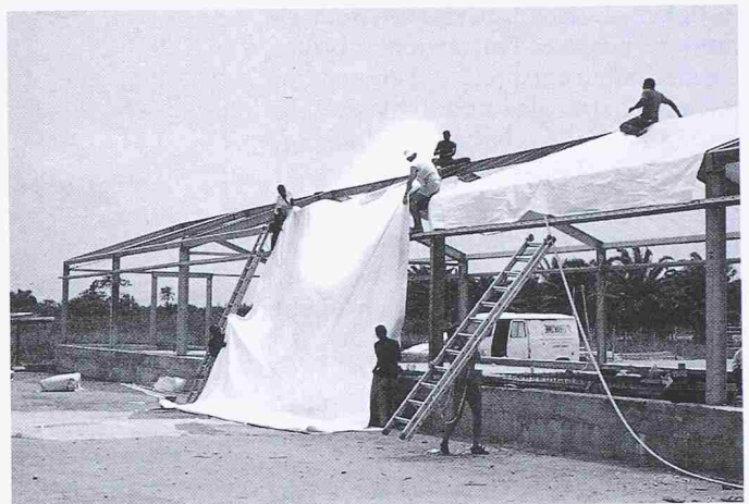
Bild 4. Montage der PVC-Sarnafil-Membrane
