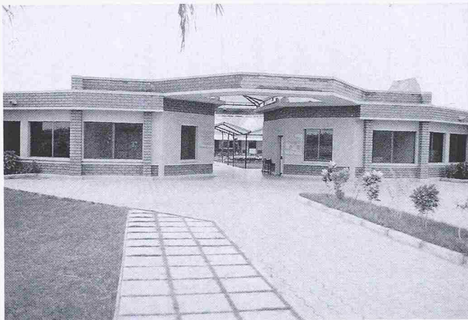
Bild 3. Eingangsbereich im Ringgebäude
