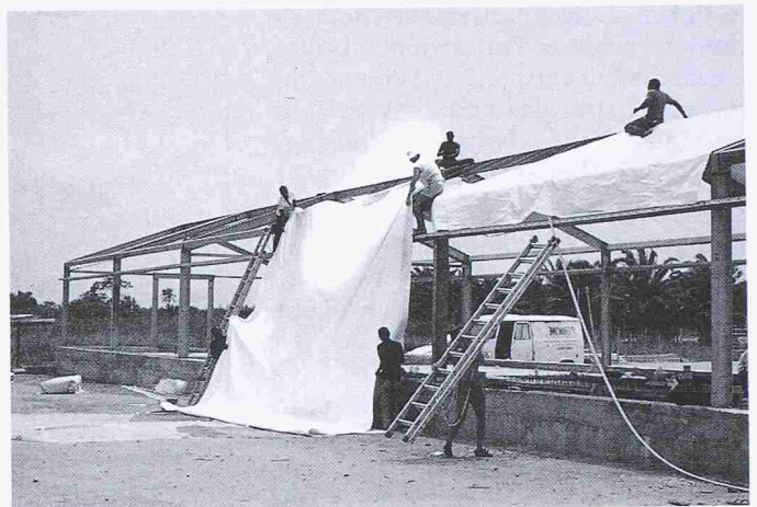
Bild 4. Montage der PVC-Sarnafil-Membrane
