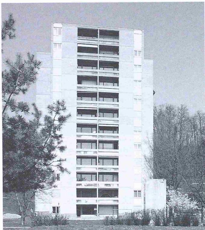
Bild 1a. Hochhaus Glattbrugg vor der Sanierung. Das Hochhaus wurde 1970 in der zu jener Zeit üblichen Konstruktion ausgeführt: Sichtbeton mit Innendämmung
