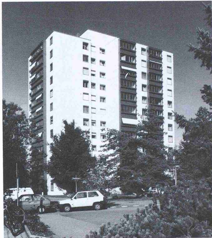
Bild 1b. Zustand nach der Fassadensanierung. Massgebend für die Auszeichnung war neben der Sanierung der Haustechnik die gute konstruktive Lösung der hinterlüfteten Fassade mit Keramikplattenverkleidung sowie die Integration der Balkone mit Faltpfenstern
