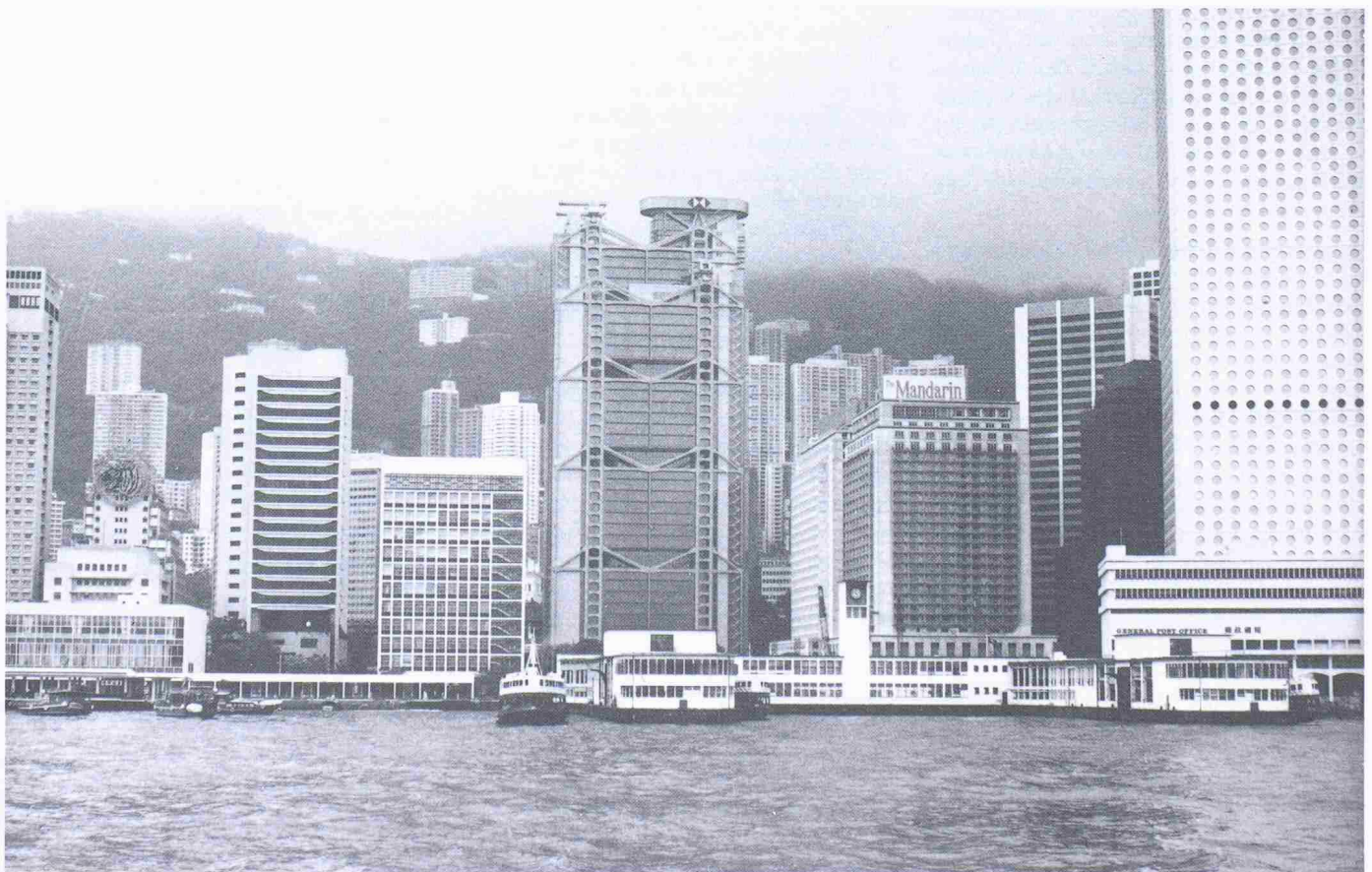
Hauptverwaltung der Hongkong and Shanghai Banking Corporation in Hongkong, 1979–1986, Norman Foster
