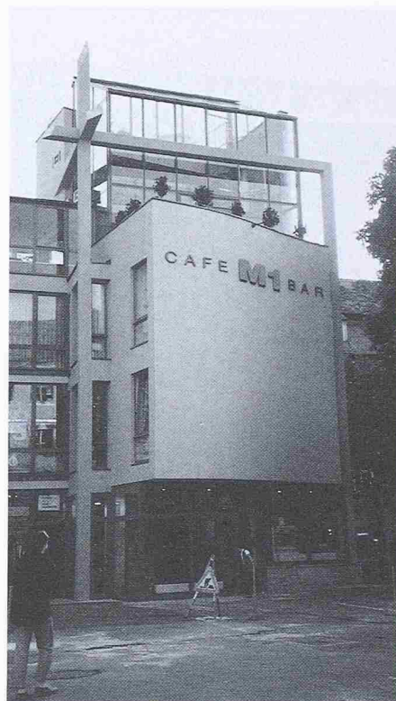
Bild 1. Gebäude am Färberplatz (Architekt R. Ellmer): Das Durchdringen von zwei prismatischen Baukörpern als Abschluss einer Häuserzeile und Platzwand (Bild: P. Hammer)
