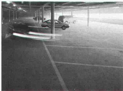
Parkdeck Glattzentrum, Wallisellen
