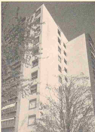
Fassadenrenovation mit Vilbofa-Elementen, Referenzobjekt in Glattbrugg ZH
