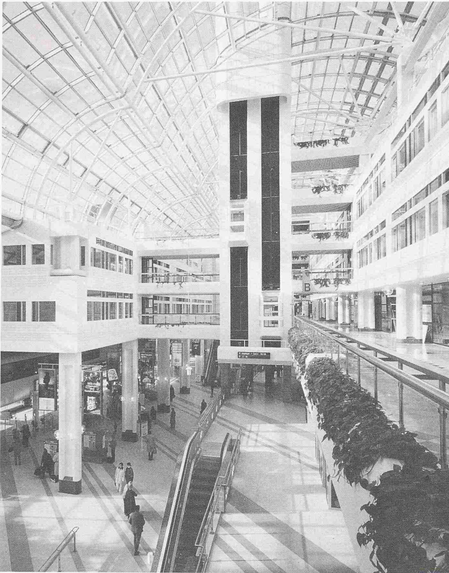
Eine der vier glasüberdeckten Hallen mit dem zentralen Lift
