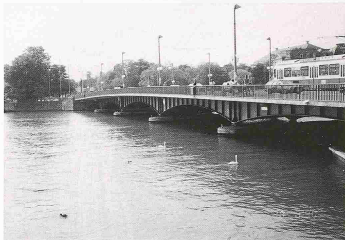
Bild 10. Quaibrücke, erbaut 1884, erneuert 1984
