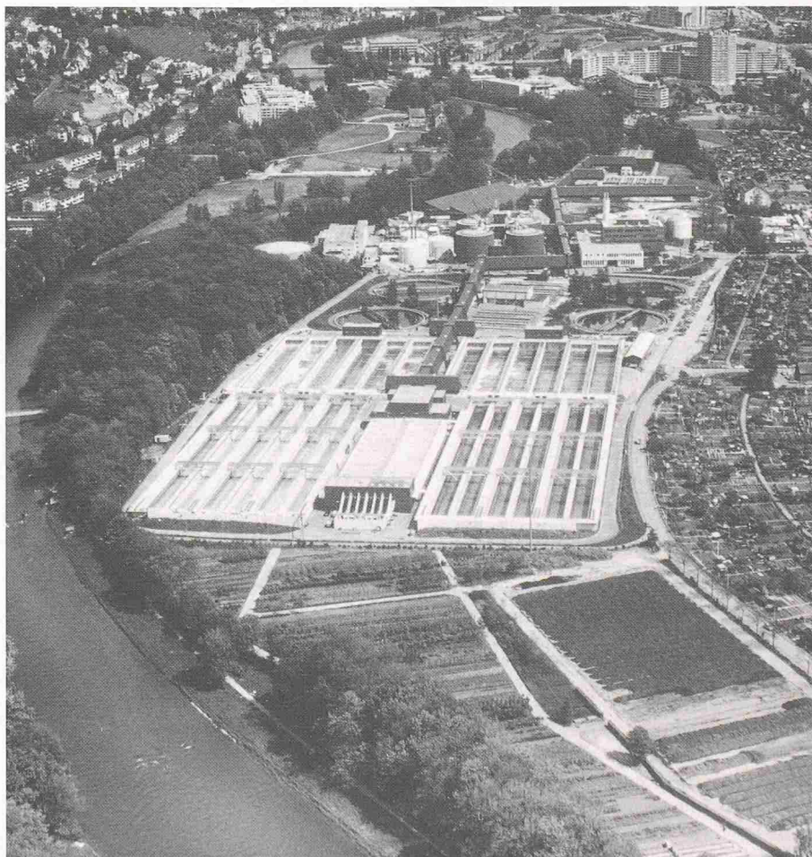
Bild 1. Kläranlage Werdhölzli: Grösstes Einzelbauvorhaben der Stadt Zürich mit einer Bausumme von rund 300 Mio Franken, realisiert in den Jahren 1980/85. Weitgehende mechanisch-biologisch-chemische Reinigung mit Filtration (rechteckige Becken im Vordergrund: Belüftungs- und Nachklärbecken, dazwischen die Filtration)
