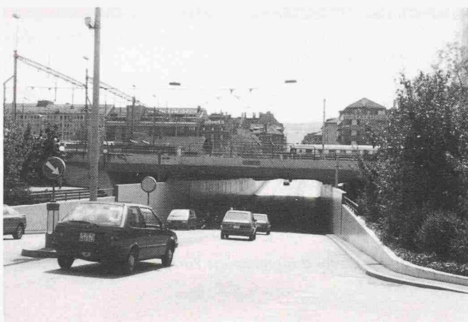
Bild 9. Militärbrücke, ehemalige schweisseiserne Hauptträger als Geländer verwendet, Spannbetonplatte als neue Tragkonstruktion
