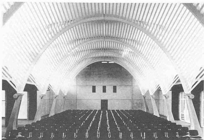
Die Feingliedrigkeit der Dach- und Deckenkonstruktion der Aula der Kantonsschule Wohlen zeigt, wie innovativ Holz eingesetzt werden kann
