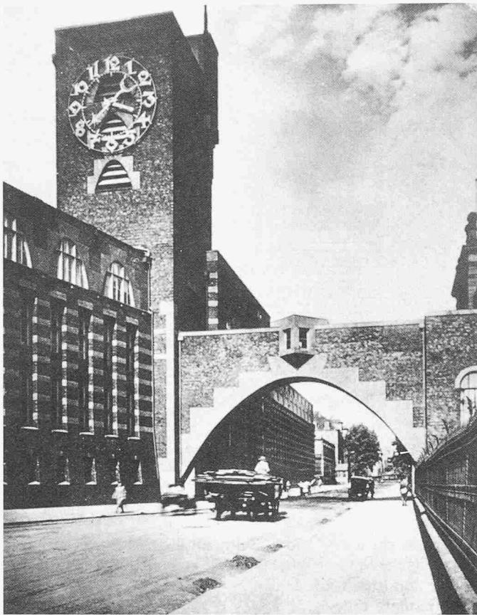
Blick von der Strasse auf Turm und Brücke der Hoechst AG, Frankfurt-Hoechst
