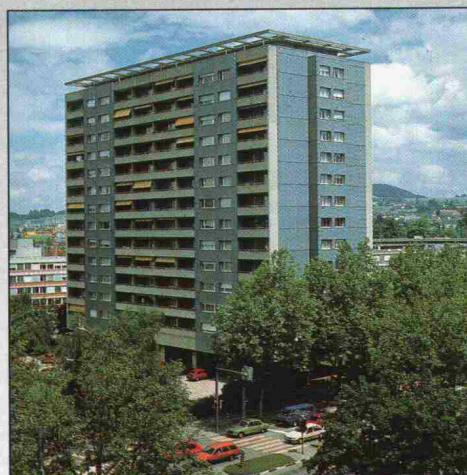
Hochhaus Aegertenhof AG, Bern Planung: Trachsel Steiner + Partner AG, 3007 Bern Ausführung der Spengler- arbeiten: Ramseier & Dilger AG, 3014 Bern
