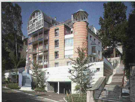
Mehrfamilienwohnhaus, St. Gallen Planung: Müller + Bamert, dipl. Arch. SIA/ETH, 9000 St. Gallen Ausführung der Spengler- arbeiten: Domeisen AG, 9016 St. Gallen
