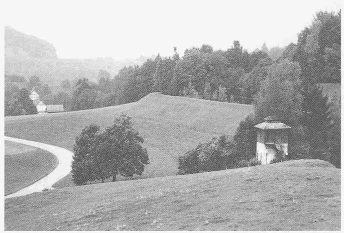
Bild 23. Der Farenbuelweiher besitzt kein eigenes Einzugsgebiet. Er wird mittels einer Druckleitung mit Wissenbachwasser gespeisen. Im Regulierturm kann der Wasserstand des Weihers eingestellt werden. Das überschüssige Wasser gelangt in den Umleitungsgraben und von dort zum Äusseren Wehier
