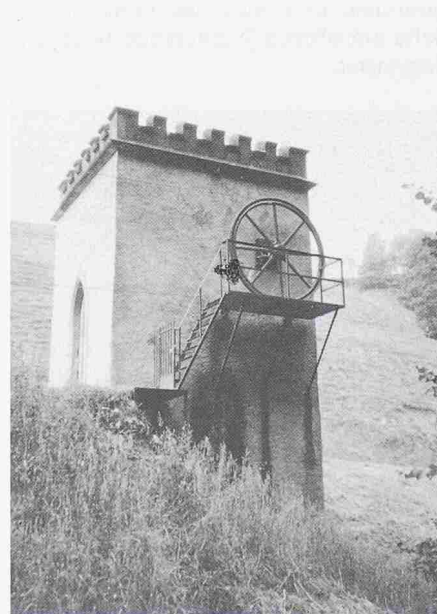
Bild 25. Turbinenturm der Seiltransmissionsanlage. An der Aussenwand des 1879/80 erbauten Turmes befindet sich das revidierte Transmissionsrad mit aufgespanntem Seil
