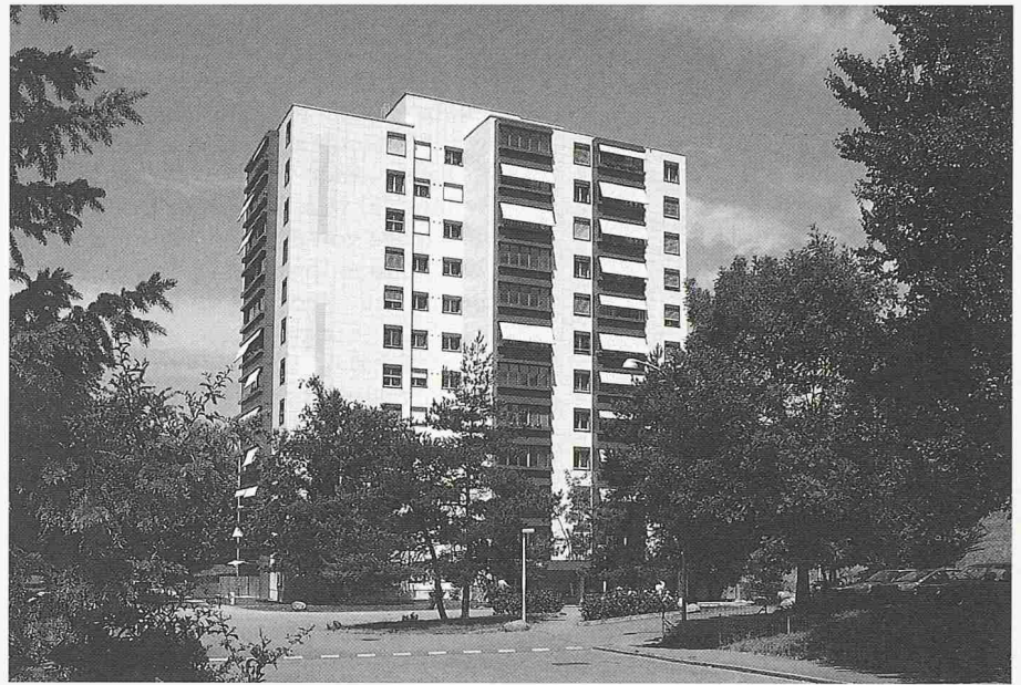
Bild 6. Zustand nach der Sanierung: Ostfassade
