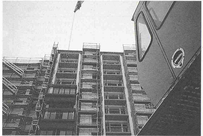
Bild 5. Versetzen der Balkonerker im November 1988
