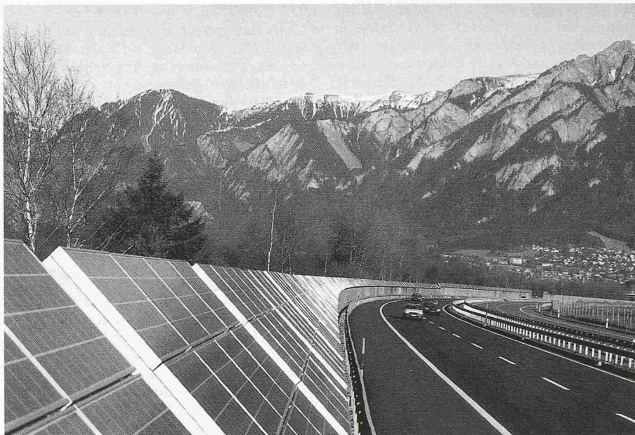
Bild 1. Das zurzeit grösste Photovoltaik-Panelfeld der Schweiz entlang der Autobahn N13 im Bündnerland
