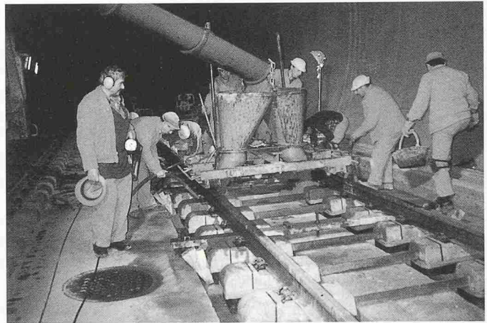
Bild 2. Einbetonieren eines schotterlosen Gleises
