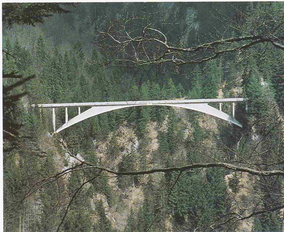
Salginatobelbrücke, 1930. Ansicht aus der Nähe. Man erkennt das Gelenk im Bogenscheitel, die kleinen Vouten des Fahrbahnträgers in den Übergängen zu den Querwänden und den Bogen, der zu den Kämpfergelenken hin an Höhe verliert
