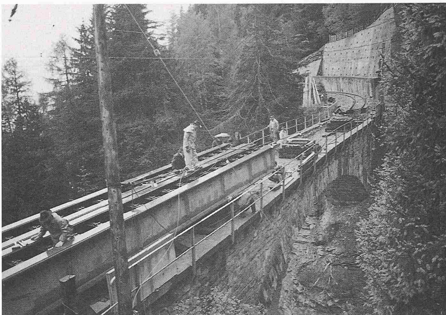
Bild 3. Einschub der Hilfsbrücke
