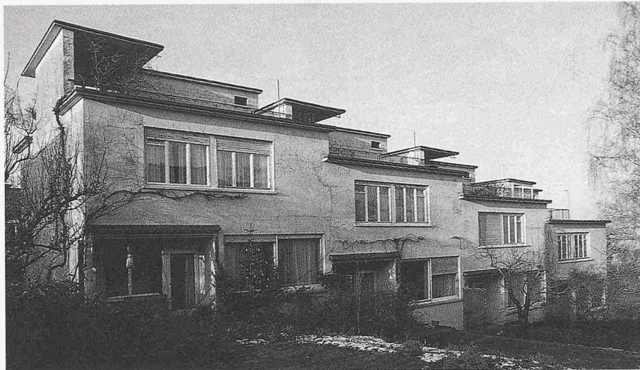
Siedlung Neubühl, Zürich, von Haefeli/Hubacher/Steiger/Moser/Roth/Artaria/Schmidt. Restauration 1987, U. Marbach und A. Rüegg (Foto: Institut für Denkmalpflege ETHZ)
