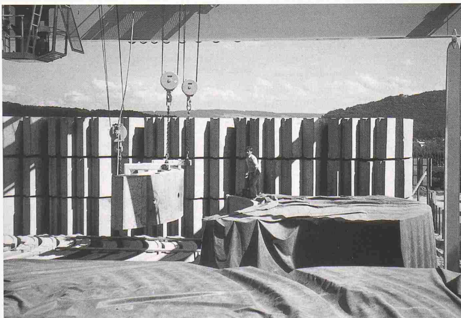
Bild 3. Tübbingnachbehandlung auf dem Lagerplatz. Abdeckung ganzer Tübbinglagen während eines Tages.
