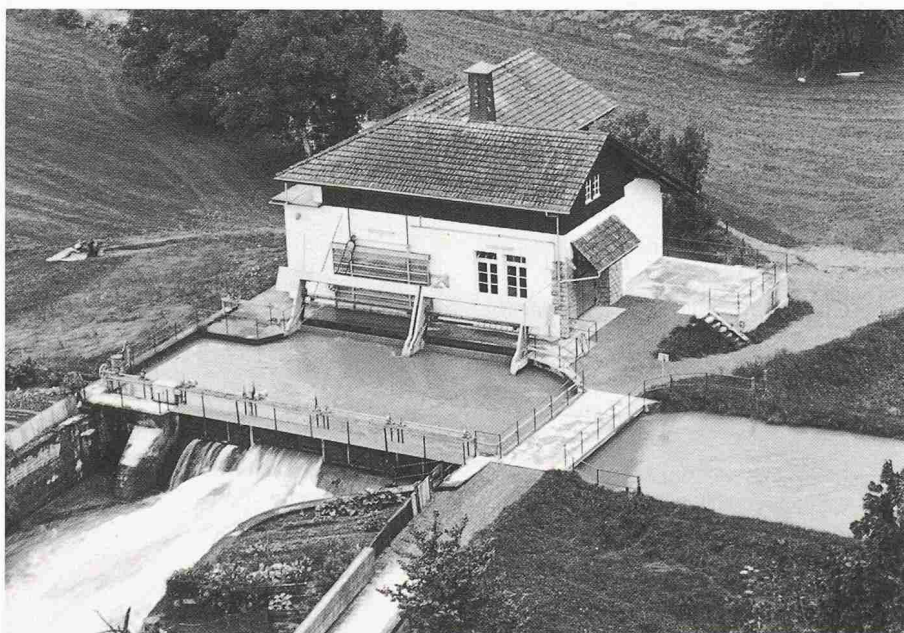
Das Kraftwerk Hürlimann in Brunnen SZ, das vor einiger Zeit durch ABB, Lenzburg, komplett modernisiert und automatisiert wurde (Bild: Asea Brown Boveri)
